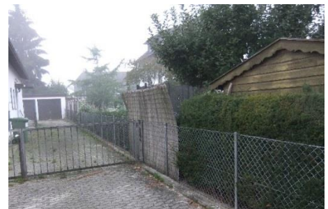
nördl. Grundstücksgrenze – Garagenzufahrt
