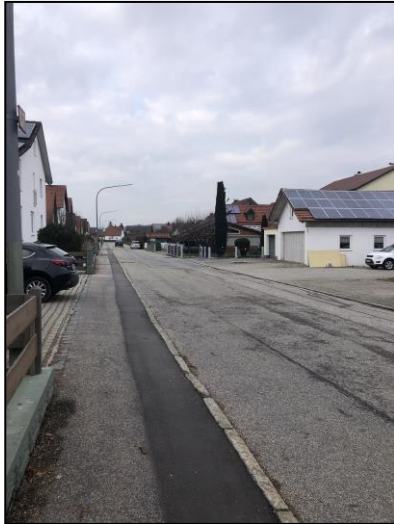
Unterwerk Straße nach Norden
